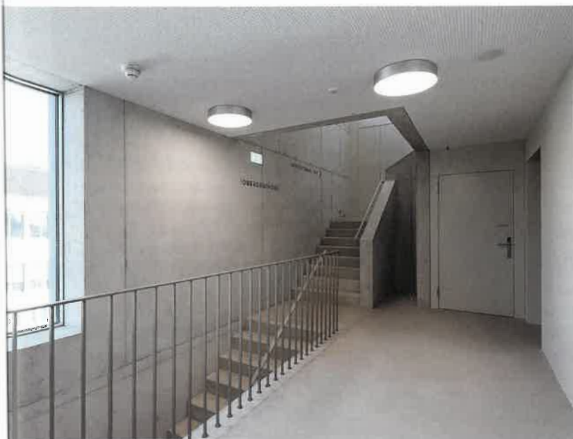
Funktional: Helle Zugangswege und Treppenhäuser sorgen für eine sichere Logistik.
